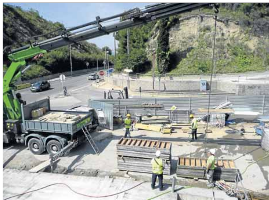
Les obres de la plaça avancen a bon ritme i ja s'ha cobert l'aparcament subterrani ■ M.M.
