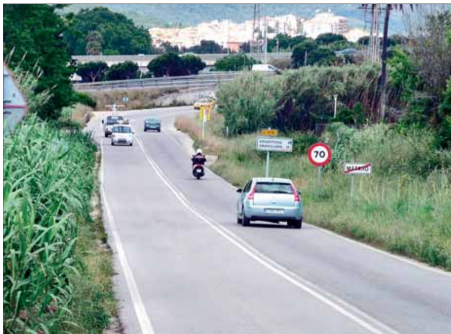
El tram de l'antiga carretera d'Argentona que ja és de titularitat municipal ■ LL.M.
